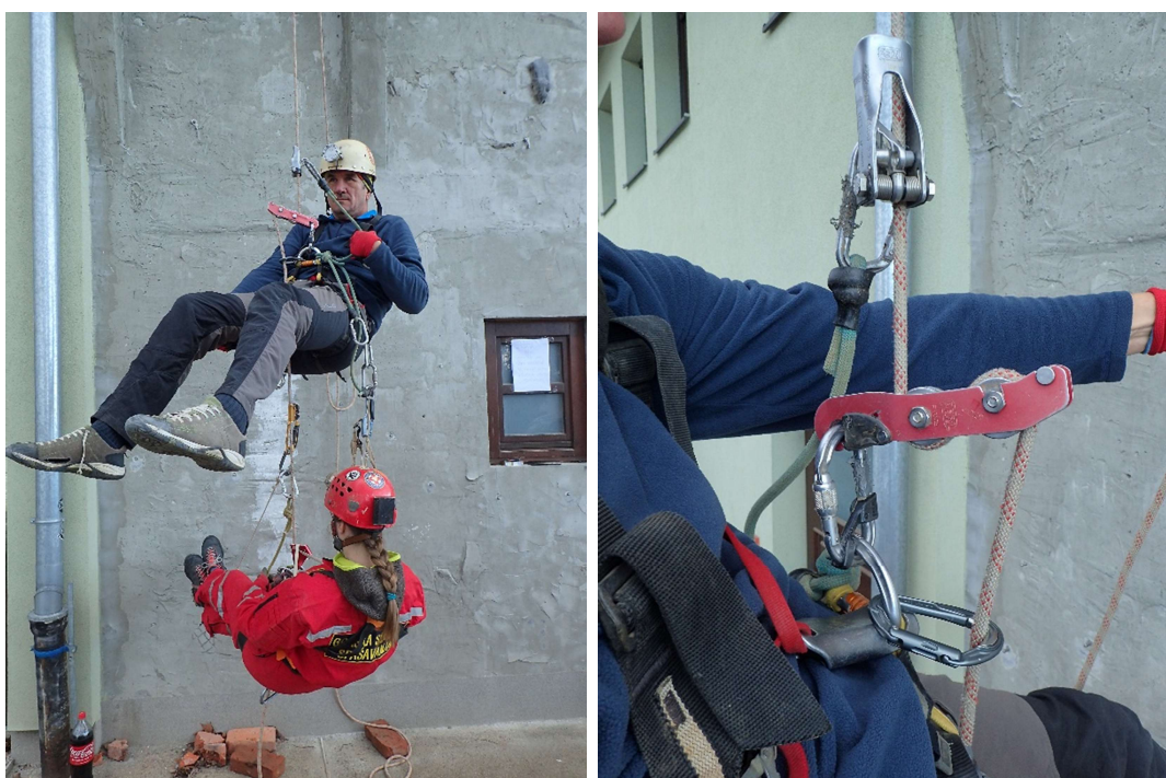
Slika 24: Položaj spuštalice prilikom izlijetanja međusidrišta
